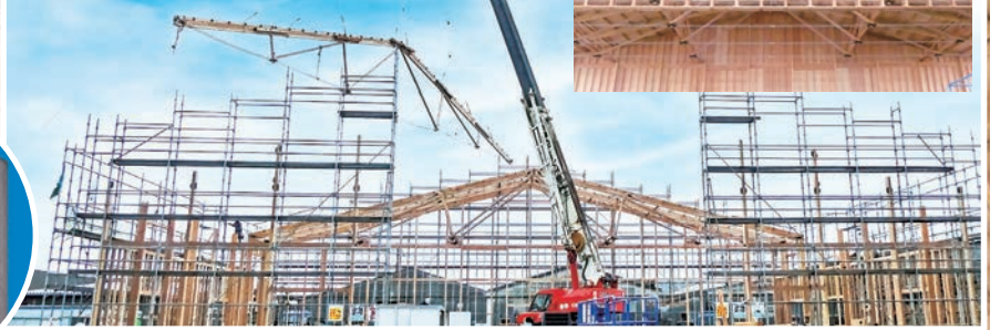
ATAハイブリッド構法で建築中の持永木材の新倉庫
