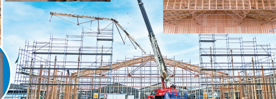
ATAハイブリッド構法で建築中の持永木材の新倉庫
